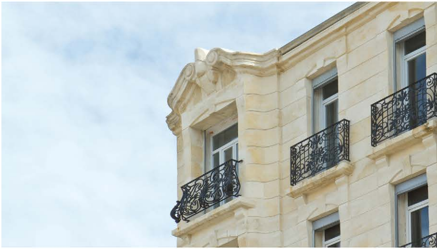
Restauration Garde-corps fonte, restauration et création Les Catalans, Marseille
